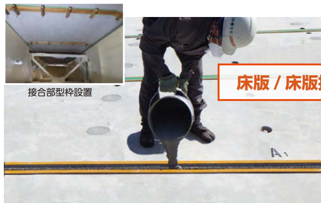
床版接合部へのELSS Joint (E) 用充填材施工
