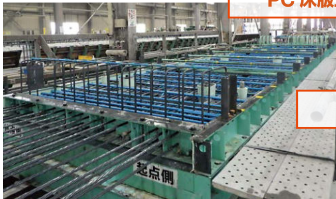
PC 床版工場製作
