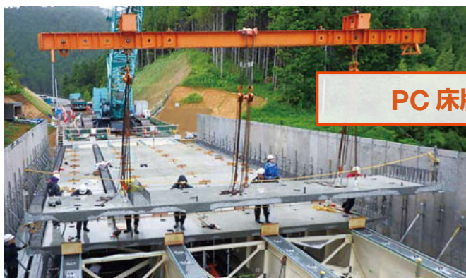
PC 床版架設
