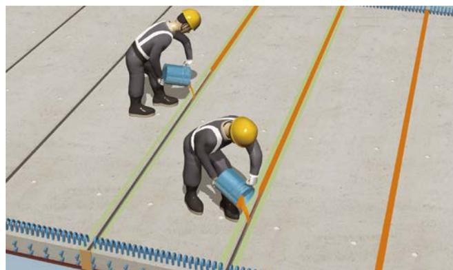
床版接合部への充填材施工
