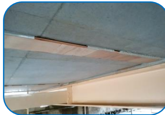
接合部型枠設置
