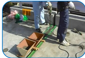
ポリマーセメントモルタル充填
