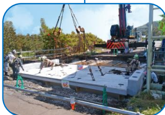
PC床版架設
